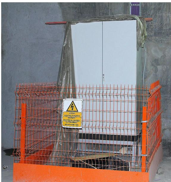
Рис. 12: Размещение щитов сбора данных в коробчатом фундаменте
