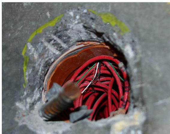
Рис. 11: Закладная деталь с кабелями тензометров, вскрытая после демонтажа опалубки стены КФ
