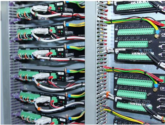
Рис. 15: Шкаф с даталоггерами системы сбора данных с датчиков КФ
