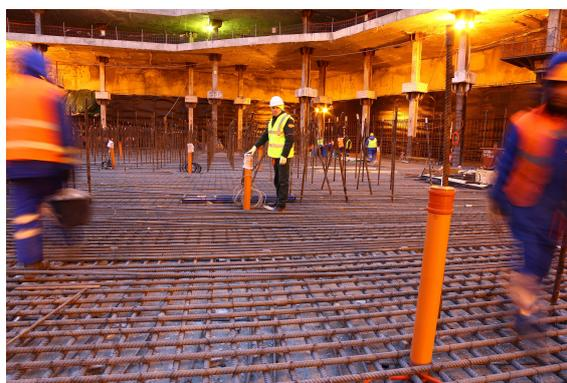
Рис. 10: Мероприятия по выводу кабелей из тела нижней плиты коробчатого фундамента
