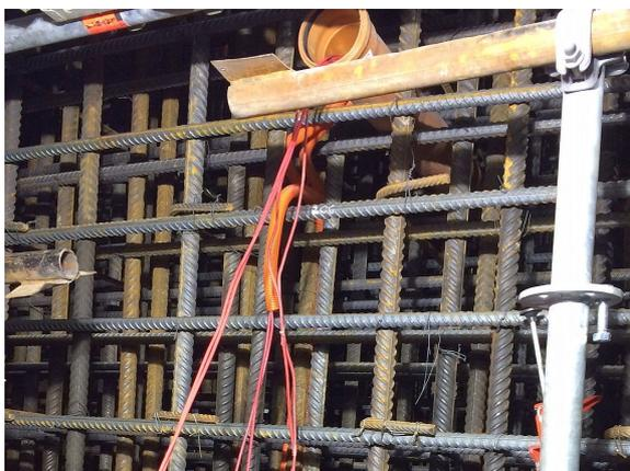
Рис. 8: Укладка кабелей тензодатчиков в закладные детали
